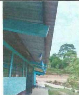
Foto 4: Colocación y mejoramiento de estructura de metal
