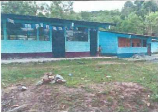
Foto 3: Colocación y mejoramiento de estructura de metal
