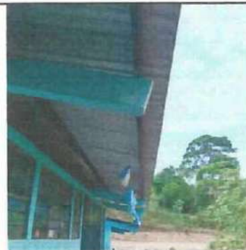
Foto 6: Colocación de canal para captación de agua
